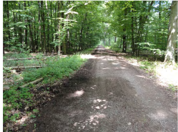
Abb.13: Forstweg in Höhe Anbindung zu Andachtsplatz 1
