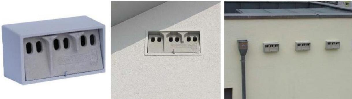
Abbildung 9: Beispiele für Koloniekästen für den Haussperling. (Quelle: [https://www.schwegler-shop.de/shop/product\\_info.php?products\\_id=227](https://www.schwegler-shop.de/shop/product_info.php?products_id=227)). (MALTEN 2022: S. 4).
